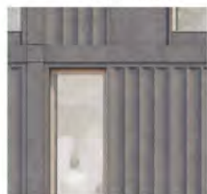
Betong, matrisgjutning. Exempel på skuggverkan.
