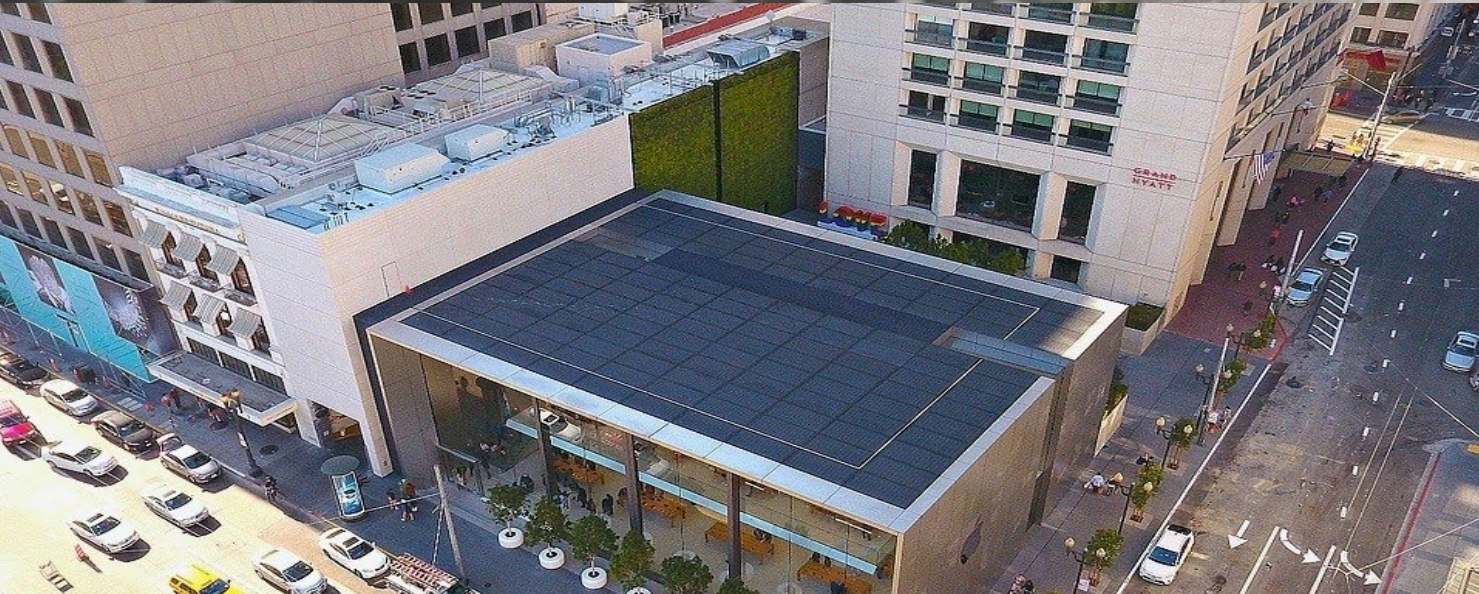
Cubierta plana transitable. Suelo fotovoltaico. Silicio monocristalino (vidrio anti-deslizante). Apple Store. San Francisco, USA.
