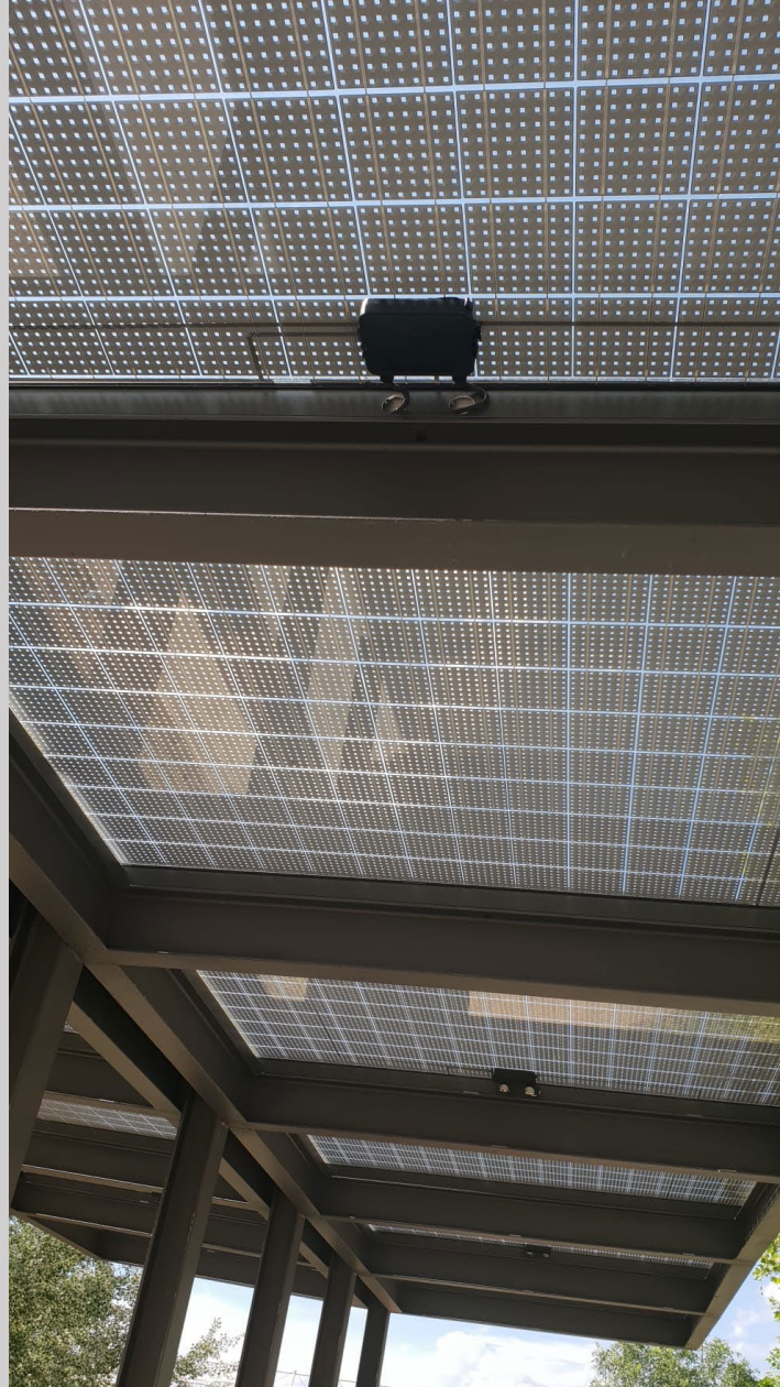
Pérgola de Silicio Monocristalino. Punto de recarga de vehículos eléctricos, Ayuntamiento de Valladolid.
