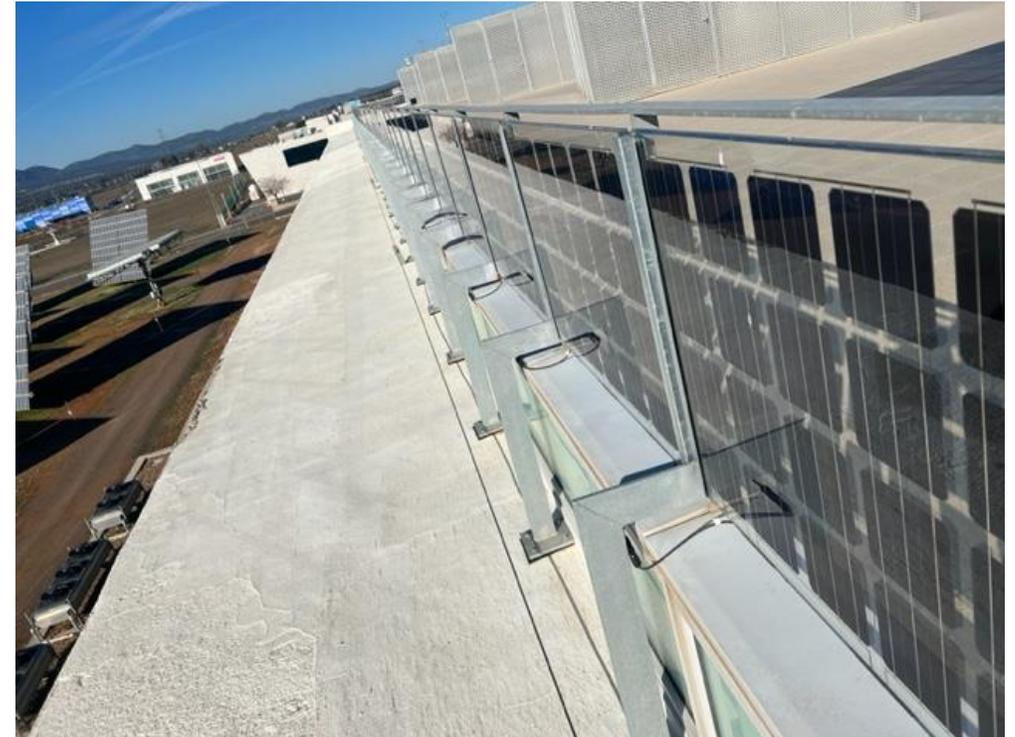
Ha sido necesario reforzar la barandilla para soportar esfuerzos y carga de viento al colocar los módulos fotovoltaicos
