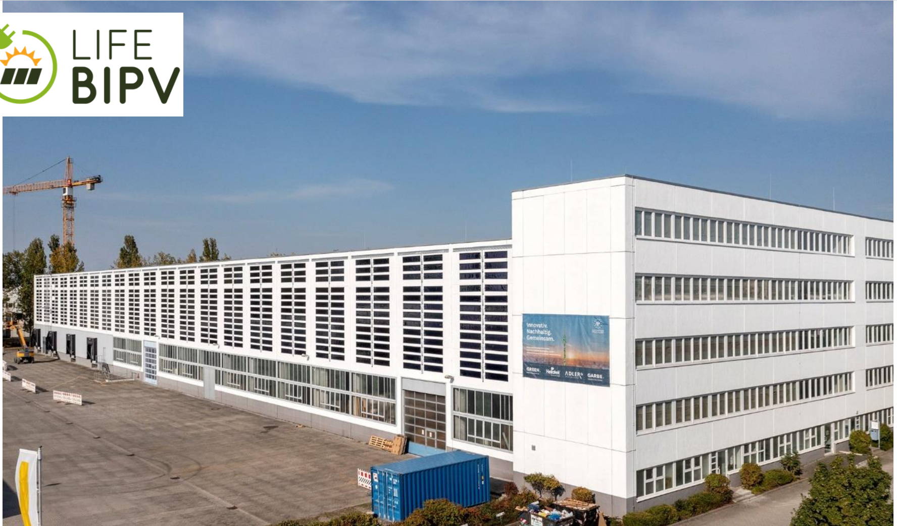
Nave industrial, Berlín – 16,4 kWp
