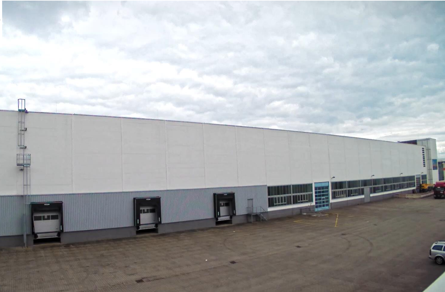
Nave industrial, Berlín – 16,4 kWp
